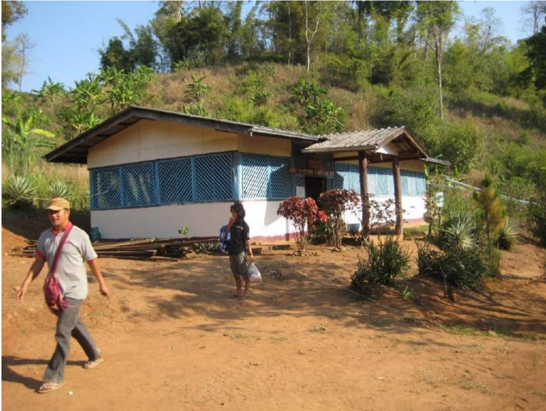
Das neue Krankenhaus in Paw Bu La Hta
